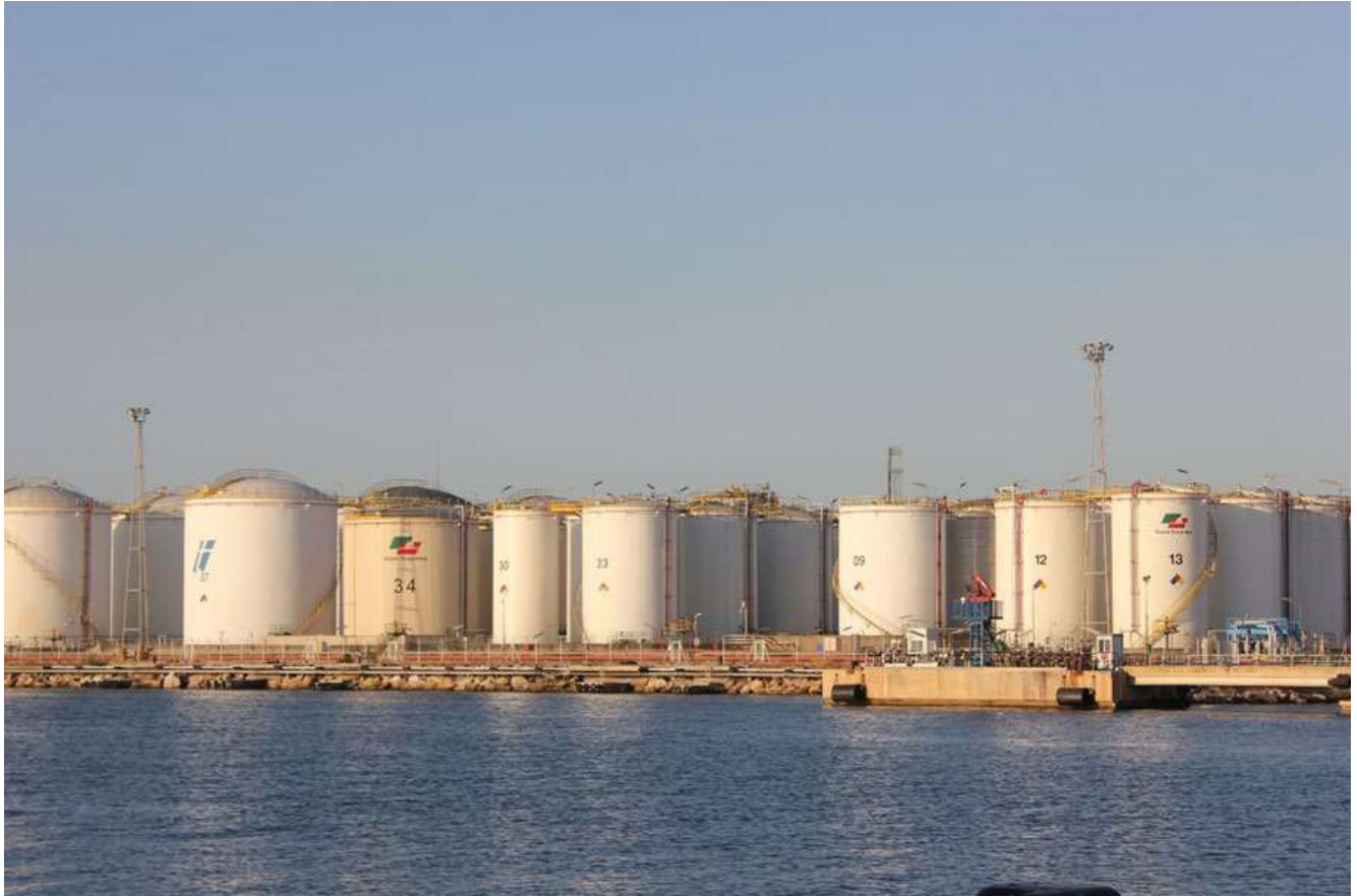
Foto tanques cilíndricos verticales de Terquimsa-2 (Tarragona)
