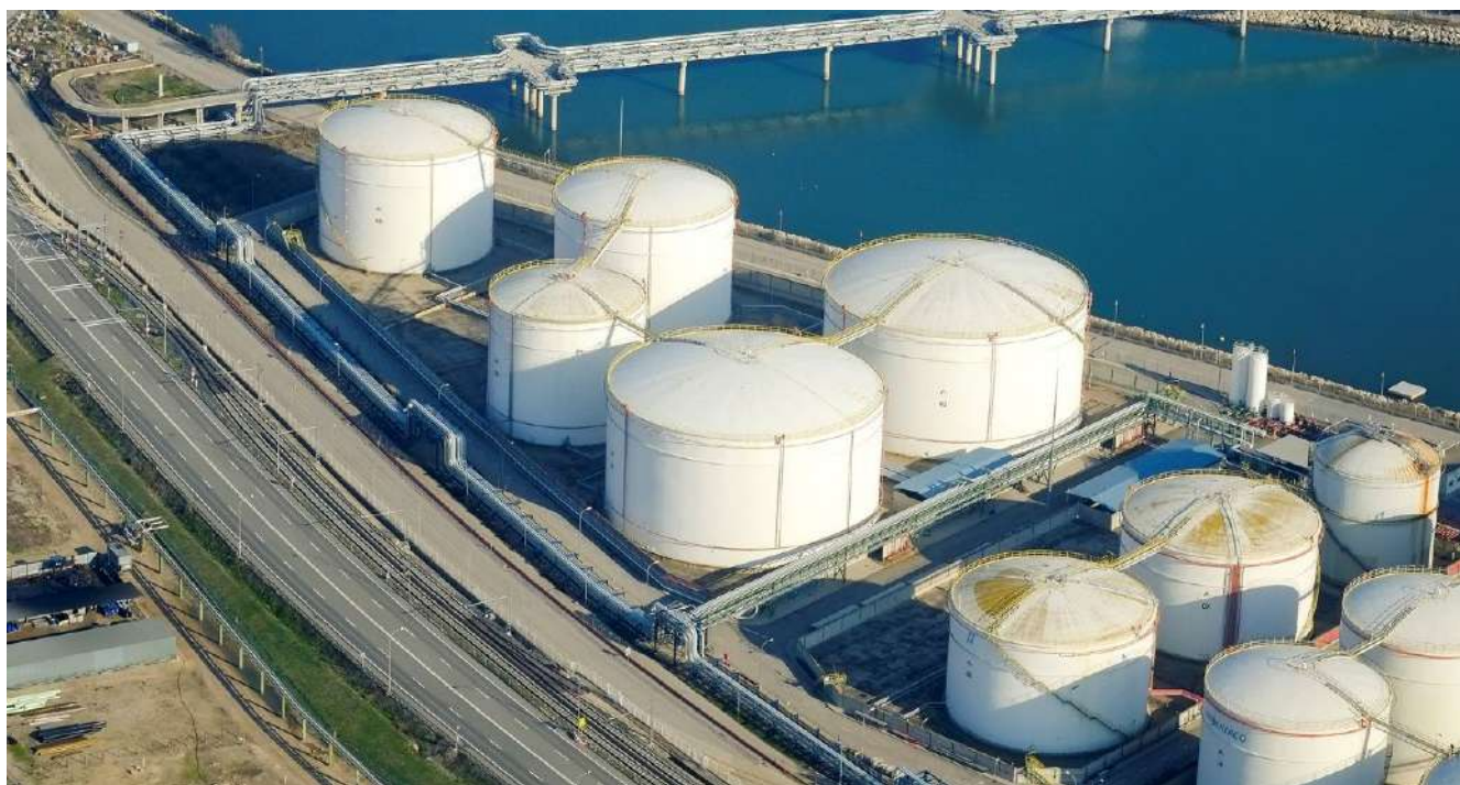
Foto: Vista aérea Terquimsa-3 (Tarragona)
